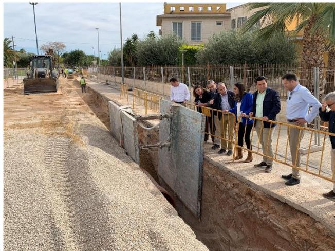
Las actuaciones consisten en la colocación de 1,8 km de tuberías de 1,8 m de diámetro en el colector principal y de 2,4 km de tuberías de un metro de diámetro en el resto. Dichos colectores confluyen en la calle Cabo Roches, frente al inicio de la calle Cabo Huertas. Desde allí se trasladan las primeras aguas de escorrentía, hasta un embalse de almacenamiento que tiene una capacidad total de 33.250 m<sup>3</sup>, que se situará frente a la parcela de la Estación Depuradora de Aguas Residuales.
