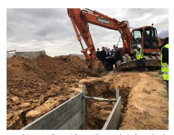
El colector de aguas pluviales, que tiene una longitud de 971 metros y una capacidad de captación de 7,12 m3/s, recogerá las aguas de la zona exterior del casco urbano desde la calle Labrador, atravesando el colegio y la calle Jaén, pasando por las calles Orense, Joaquín Blume y Avenida 13 de Octubre, hasta entroncar con la avenida de La Libertad hasta la calle Telégrafos.
